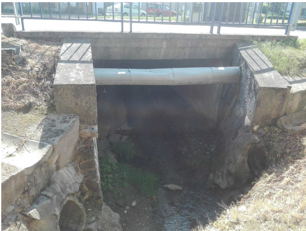
Fotografie č.2 – Pohled trubicí zaústění pod mostem
